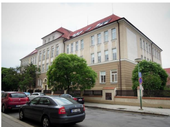
10. Základní škola v Hálkově ulici č. 4 v Olomouci, kde se měli Wolfovi 22. 6. 1942 přihlásit k transportu do Terezína, dnešní stav
